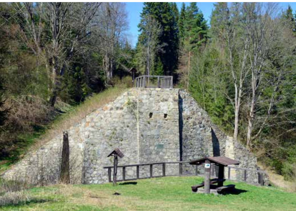
Zrekonstruované pilíře vysokého mostu
